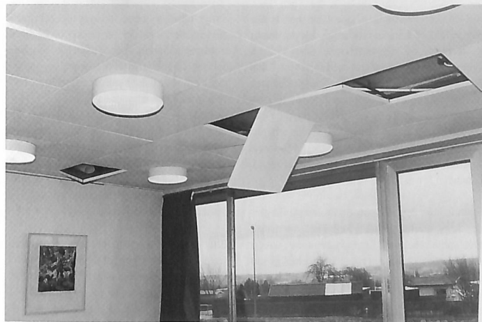
Lofterne før renovering
